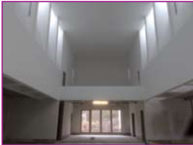
Das Innere der Genezareth-Kirche kurz nach Verlegung des Estrichs im März
