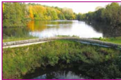
Staumauer im Broichbachtal, durch das der Pilgerweg am 17. März führt
