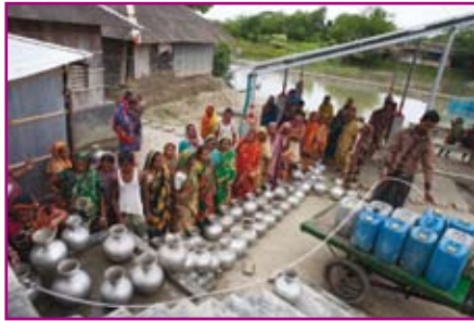
Menschen holen sauberes Trinkwasser aus der Reverse Osmosis Wasseraufbereitungsanlage in Shyamnagar, Satkhira, Bangladesch.
