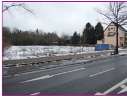
Die Baustelleneinrichtung Mitte Januar
