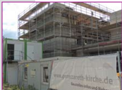
Rohbau der Genezareth-Kirche
