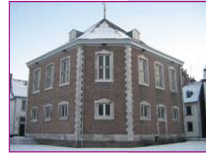
Heute ein Museum - aber früher eine ev.-lutherische Kirche, die Aachener Protestanten 1736 bauten: De Kopermolen in Vaals
